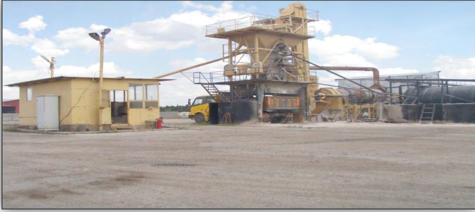
HAVSA ASFALT PLENTİ
