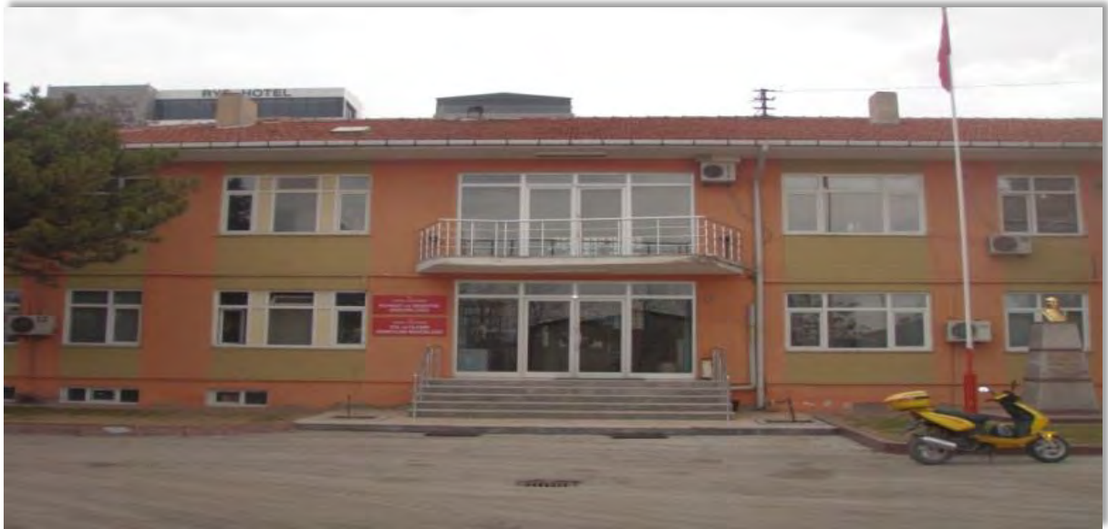
Tarımsal, Yol ve Ulaşım ile Ruhsat ve Denetim Müdürlüğü'nün hizmet sunduğu 2 katlı ek hizmet binası
